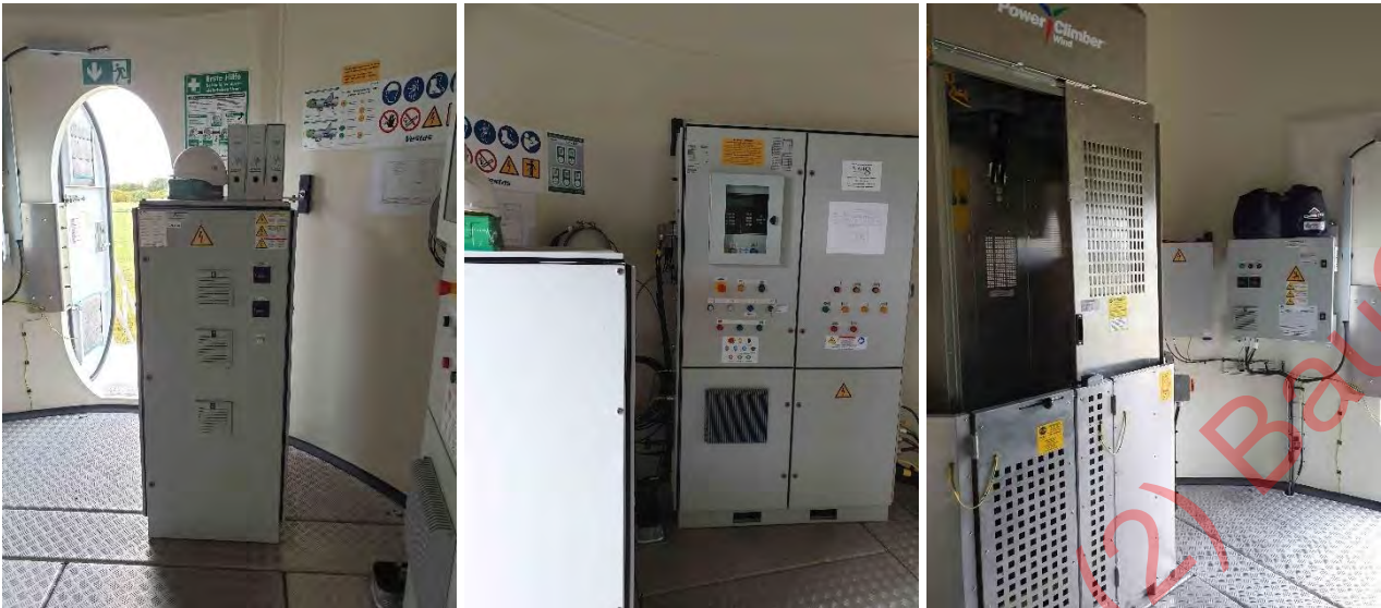
Abbildung 5-1: Schränke mit elektronischen Geräten im Turm der Anlage
