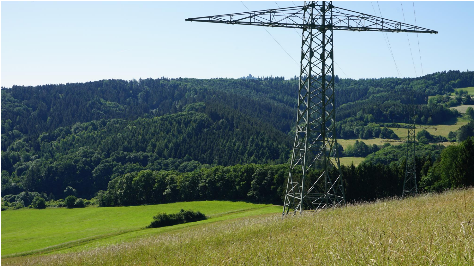
Blick von östlicher Richtung auf das Plangebiet und die Nürburg (unverändert)
